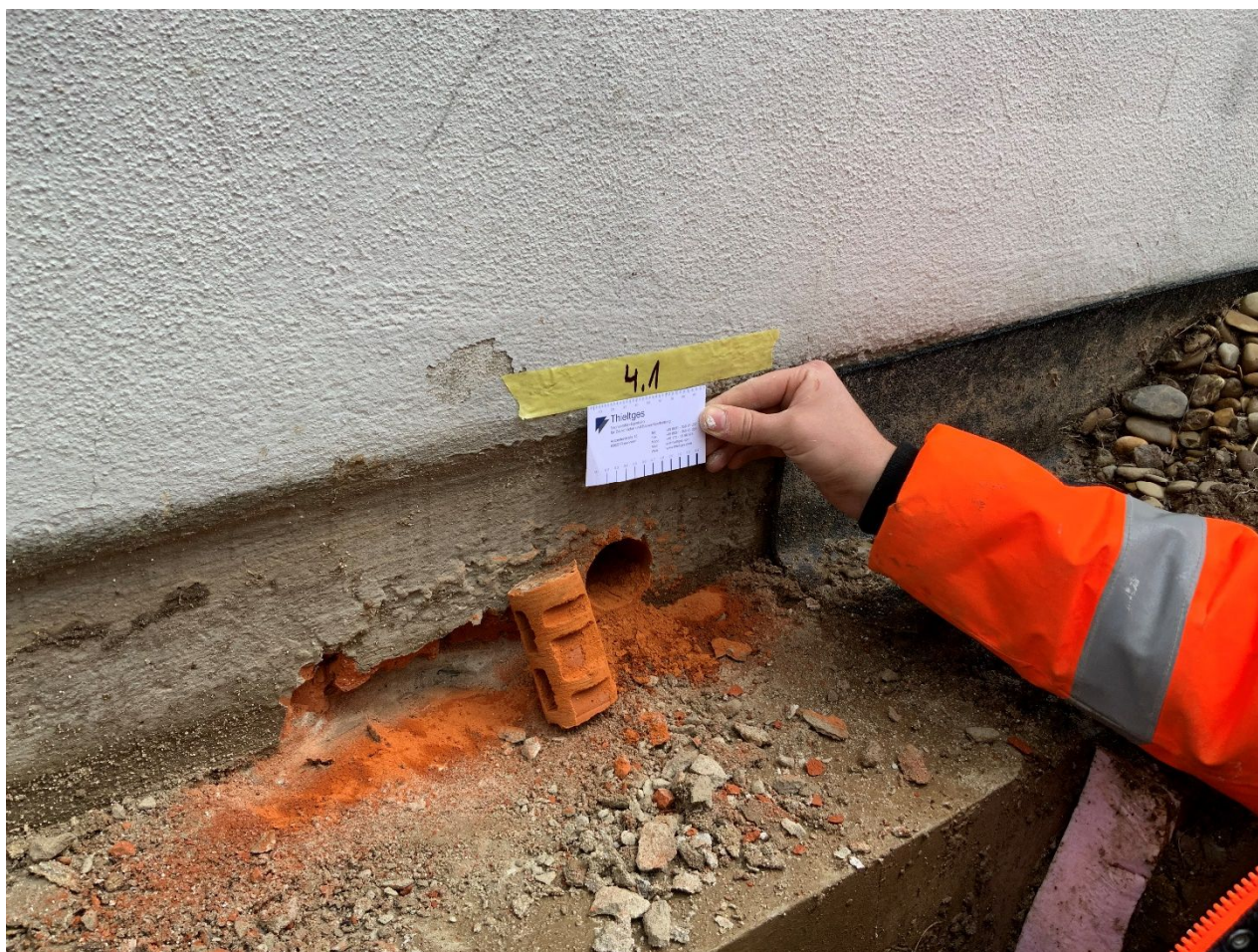
Abb. 13: Bauteilöffnung Westseite (Nr. 2)
