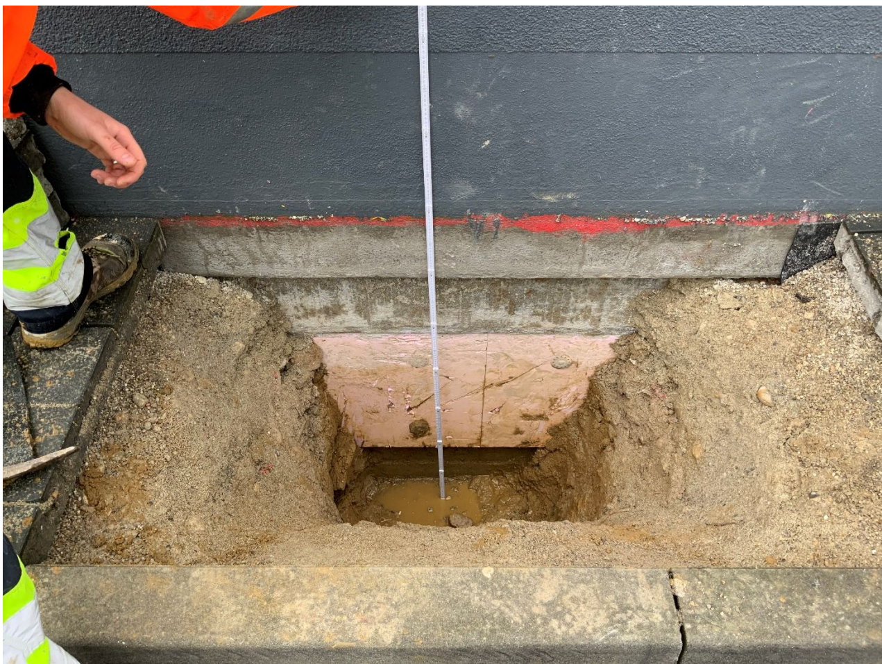
Abb. 2: Bauteilöffnung Nordseite
