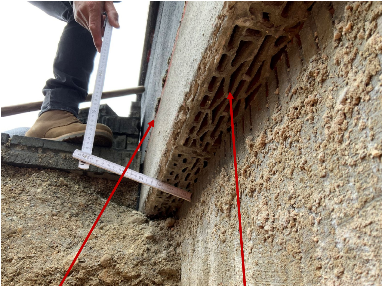
Abb. 3: Bauteilöffnung Nordseite
